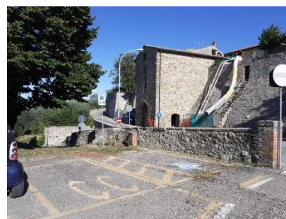
Parcheggio via Circonvallazione: scarsa manutenzione del posto auto riservato ai soggetti diversamente abili
